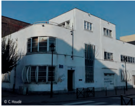
Rue Jorez, (angle de la rue de la Clinique), 21-23 - Architecte Charles Gryson, 1935
