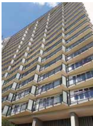
Les travées désaxées
