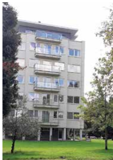
Immeuble allée des Novateurs
