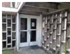
Entrée du pavillon en claustra
