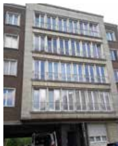
Immeuble côté rue
