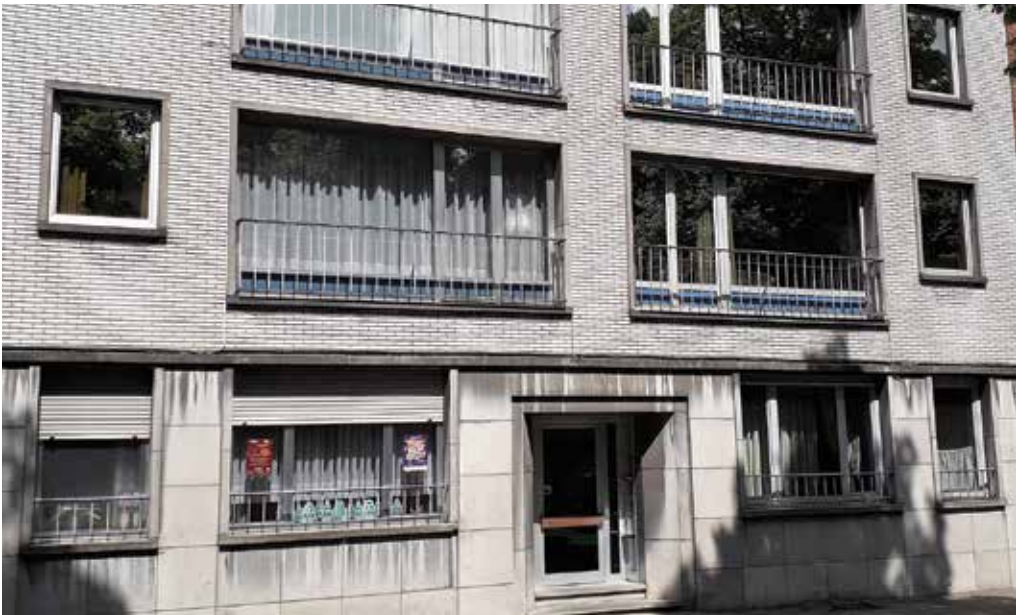
Immeuble avec panneaux de glasal
