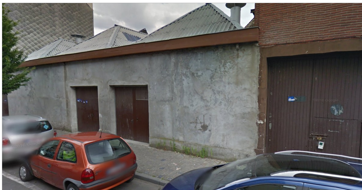
Image 3. Photo de la façade à rue
