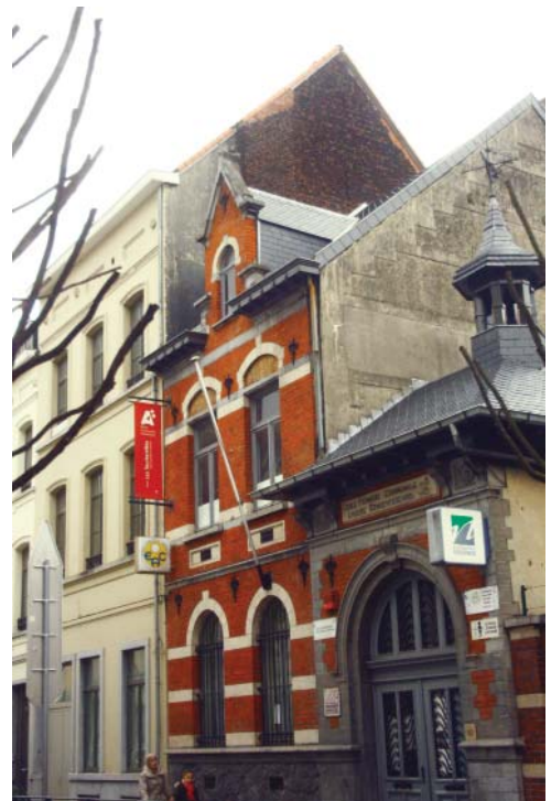
Équipement enseignement rue Odon
