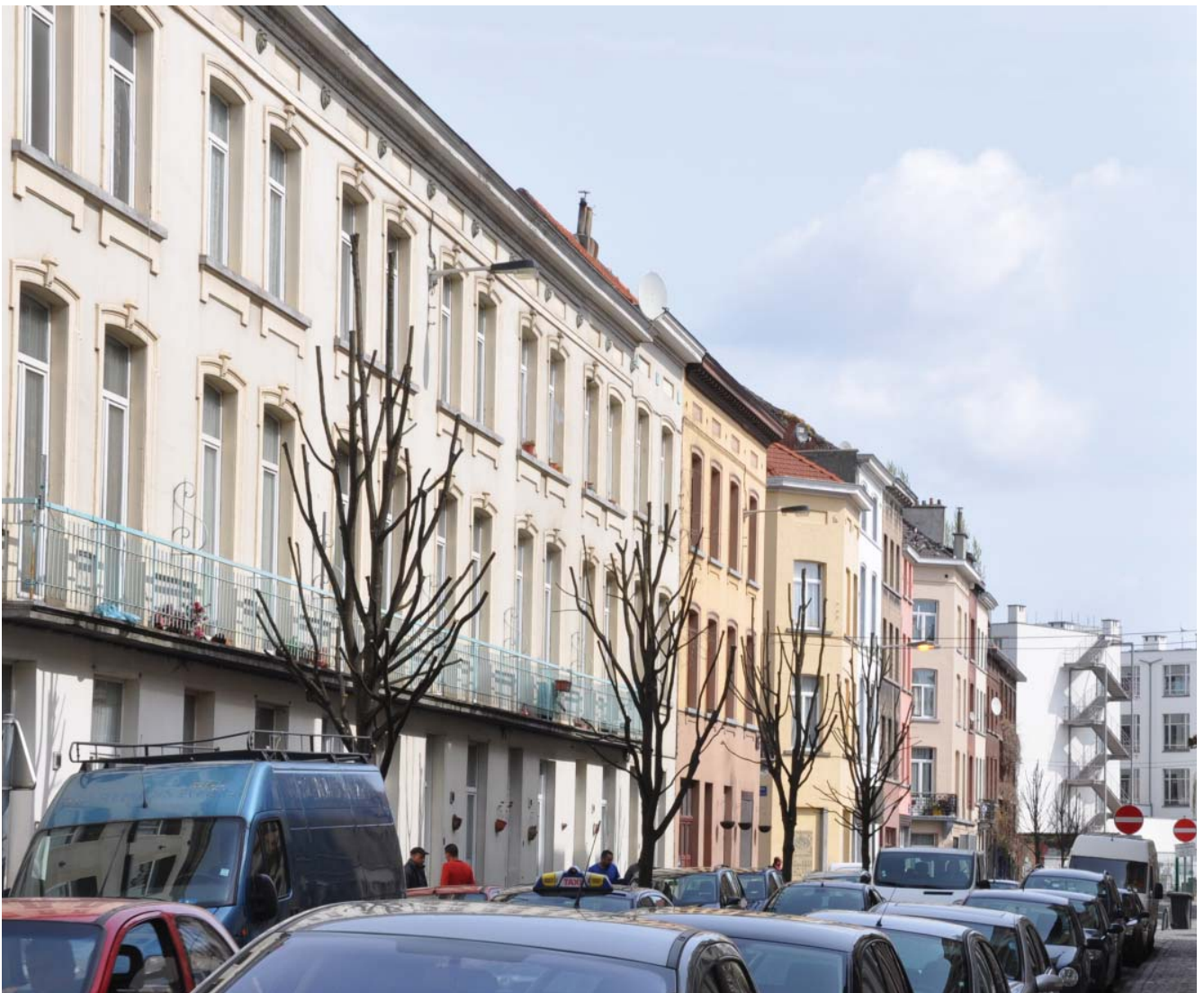
Façades rénovée rue Odon
