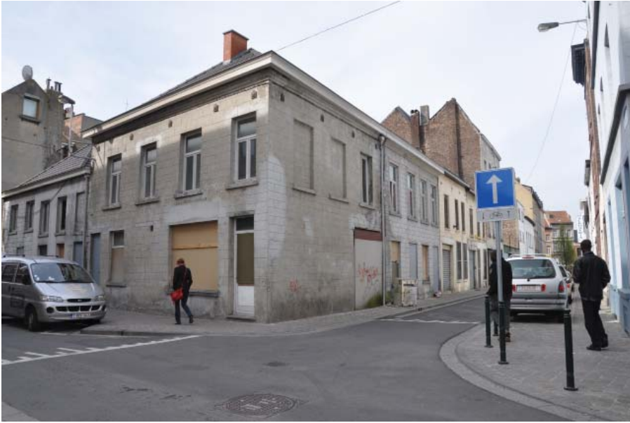
Logements vides rue Haberman
