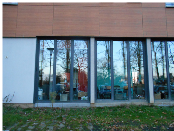
RDC Bloc 3 façade Nord
