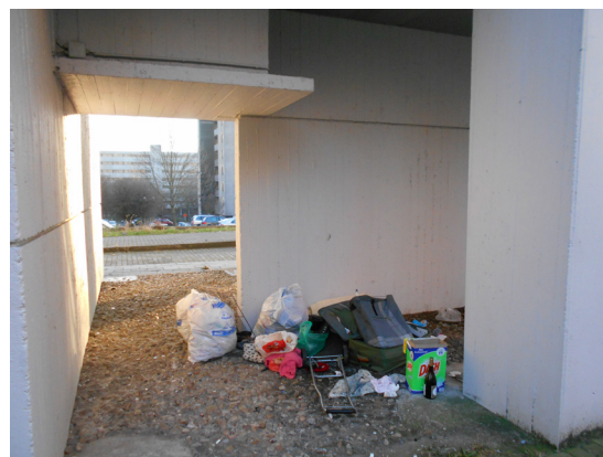
Espaces traversants au RDC du bloc 8
