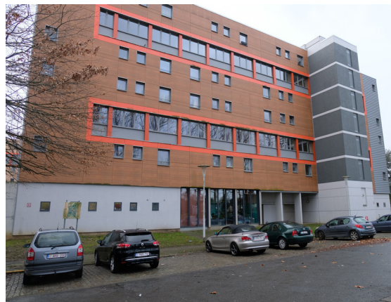
RDC Bloc 3 façade Nord
