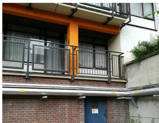
RDC Bloc 9 façade Est (Côté équipement)
