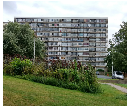
Bloc 9 façade Ouest
