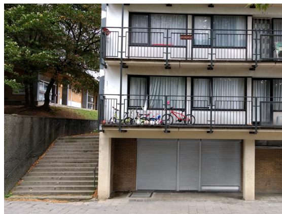
RDC Bloc 9 façade Ouest (côté Mail arboré)
