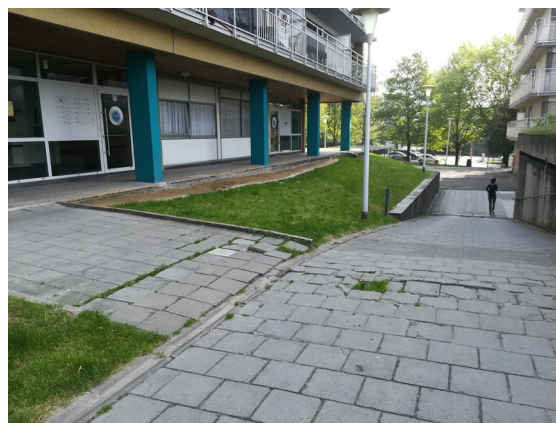
Entrées sud du Bloc 7
