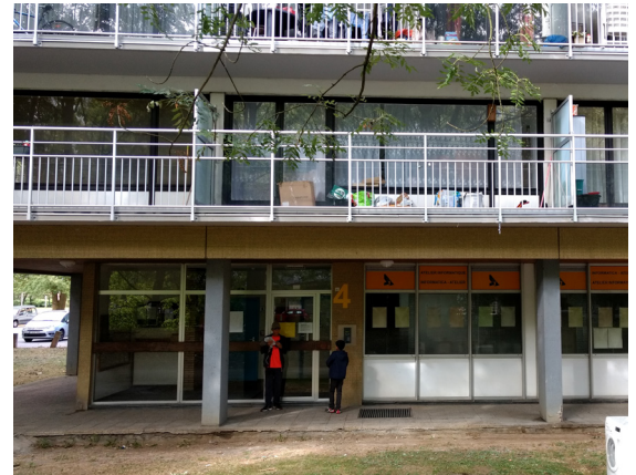
RDC Bloc 4 façade Sud
