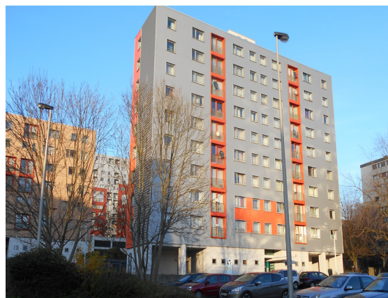
RDC Bloc 8 façade Sud (côté place de l'eau)
