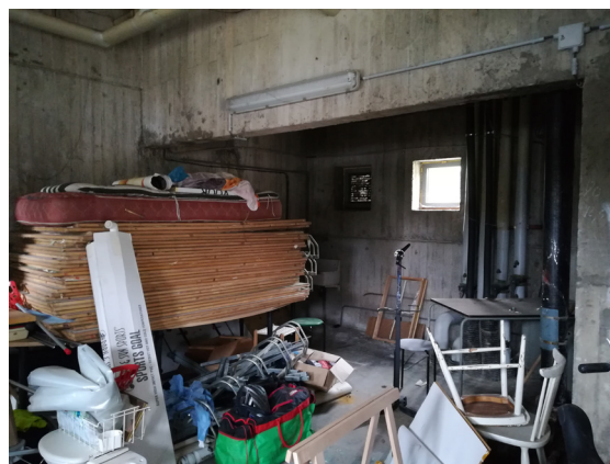
Intérieur du RDC Bloc 8
