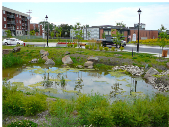
Bassin de rétention d'eau - Levis, Québec
