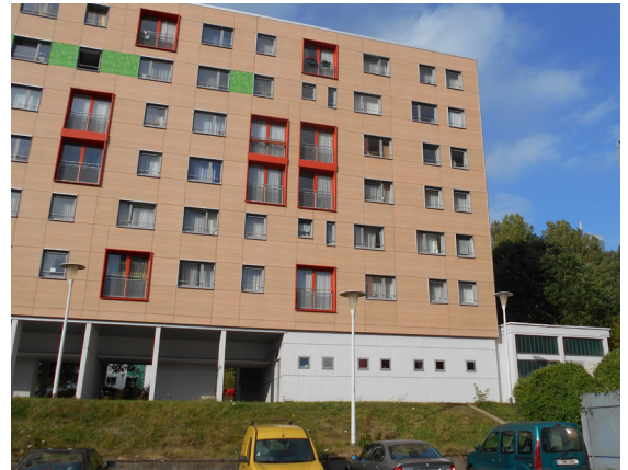
RDC Bloc 6 façade Sud
