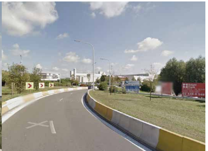
2. Aménagement autoroutier de la rue de la Bienvenue
