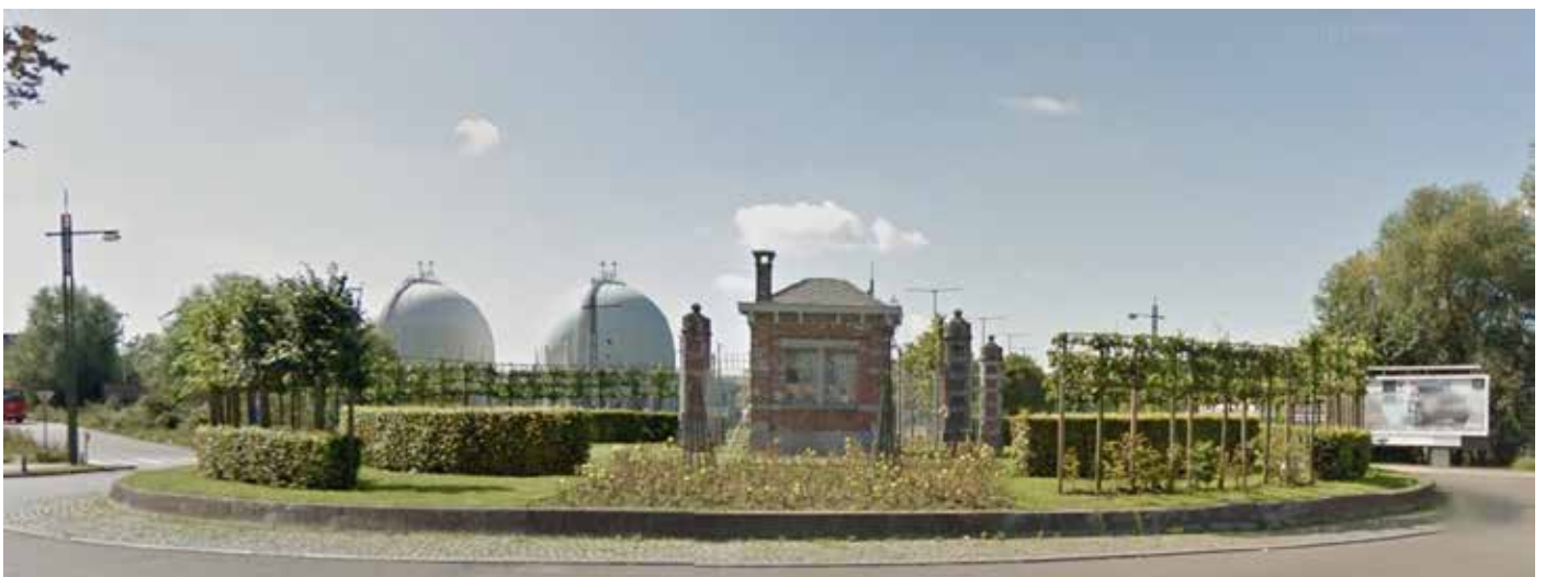
6. Rond-Point réaménagé sur le bld Industriel. En arrière plan les réservoirs Fluxys. A droite la publicité, omniprésente le long du boulevard.
