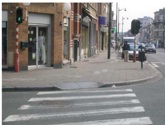
La bordure a une pente trop importante et l'orientation de la bordure dirige le PMR vers la chaussée et non dans l'axe du passage piéton. On utilise de préférence les bordures de ce type dans les sections droites.
