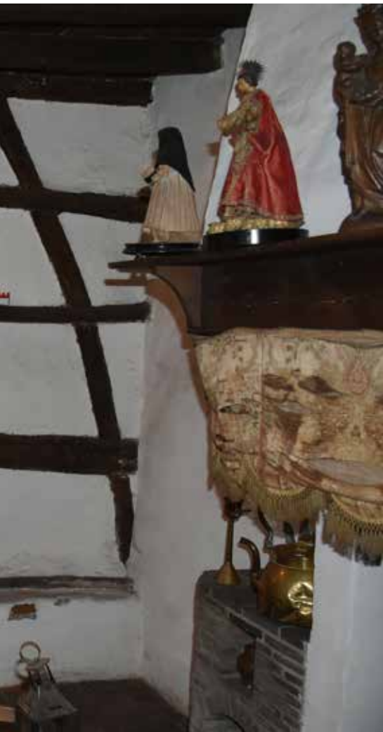
L'ancienne chaumière en colombage : photographie du mur de refend intérieur sur lequel la cheminée prend place Het oude vakwerkhuisje met rieten dak: foto van de binnenmuur waarop de schoorsteen zich bevindt © urban.brussels-UlB
