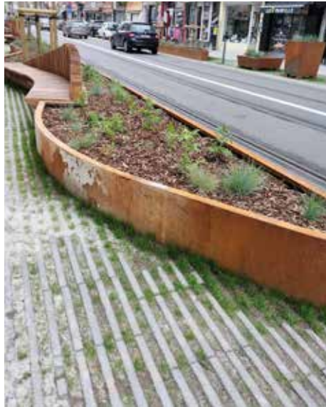
Les nouveaux trottoirs de la rue Wayez comprennent plusieurs zones où l'eau pluviale peut s'infiltrer naturellement dans le sol - de nouvelles voies piétonnes dans la rue Wayezstraat bevatten verschillende zones waar regenwater op natuurlijke wijze in de grond sijpelen.
