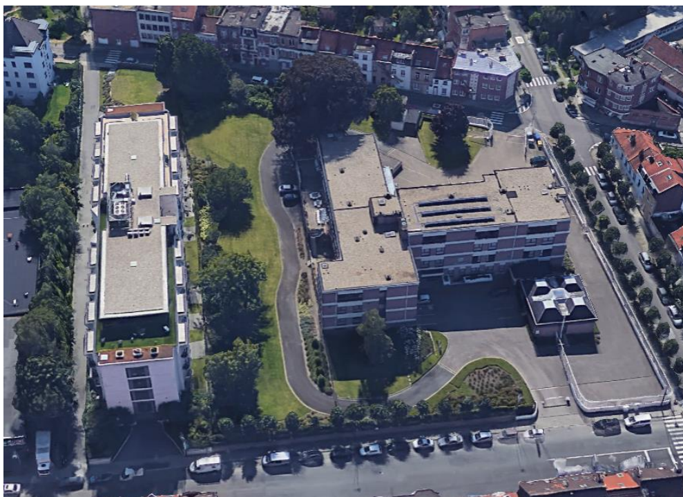
Figure 38 : imperméabilisation d'une partie importante des abords de la zone de variation de masse autorisée par le PPAS dont les prescriptions sont peu contraignantes en matière de plantation.
