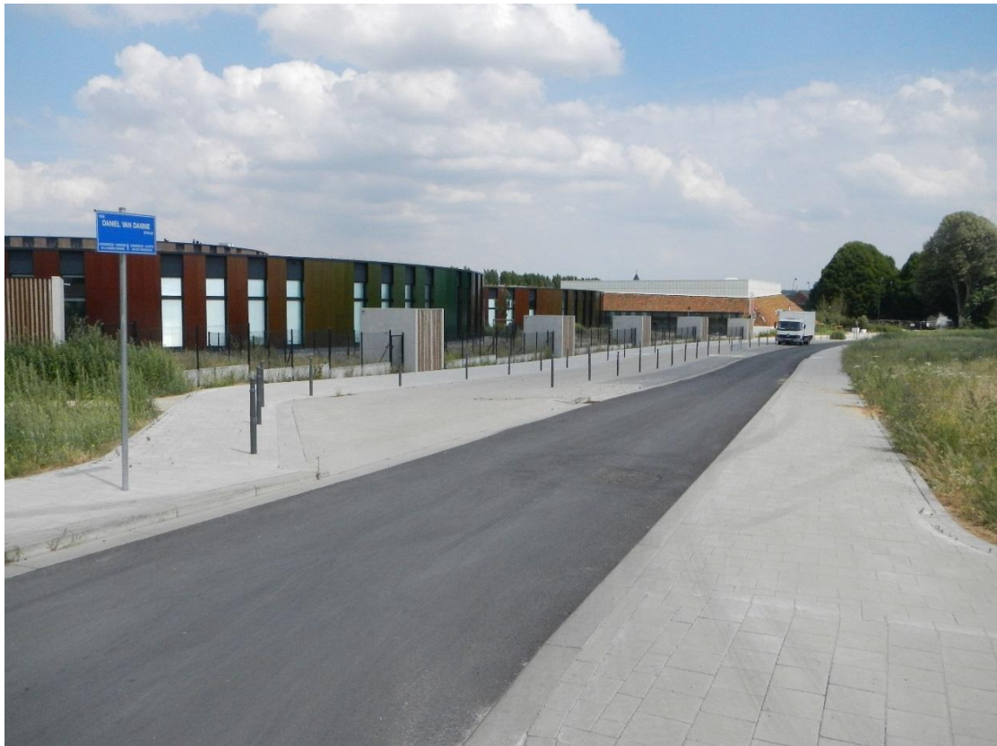
Figure 4-5 : Nouvelle école située entre la Rue Delwart, la Rue James Cook et la nouvelle Rue Daniel Van Damme (Source: visite sur le terrain juin 2017).
