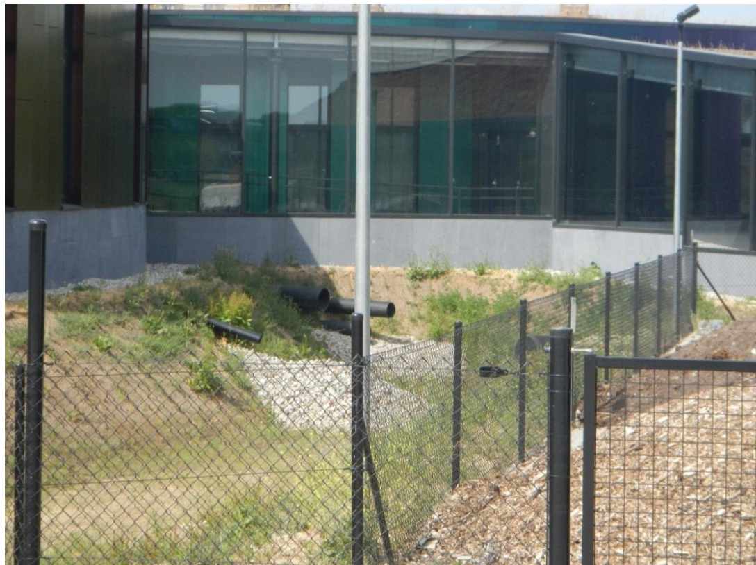
Figure 4-18: Bassin d'orage à l'air libre à hauteur de l'école (Source : visite sur le terrain juin 2017).
