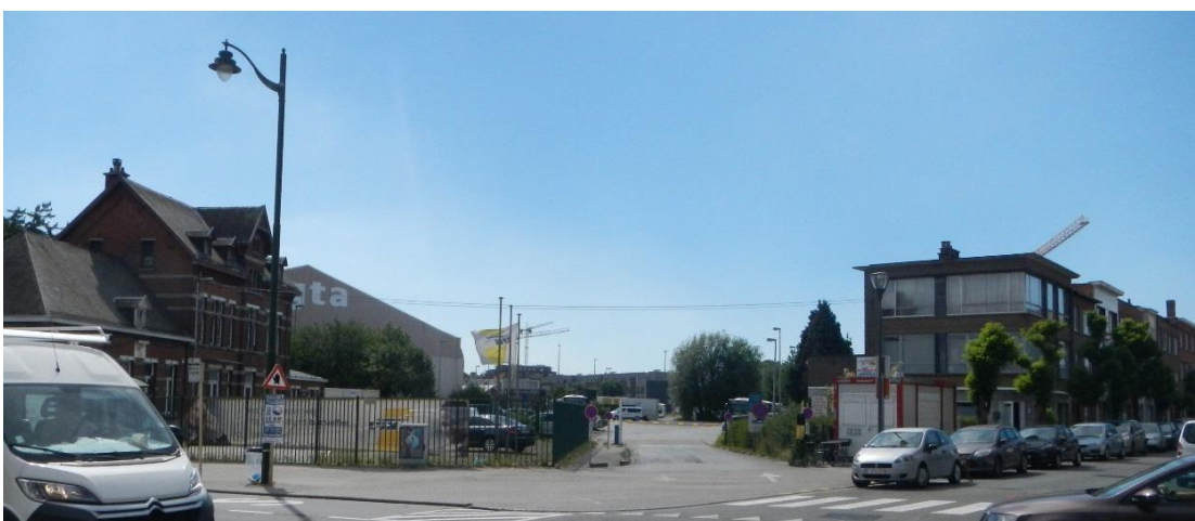
Figure 4-4 : Site de De Lijn au moment de l'élaboration du PPAS (au-dessus, Source: reportage photographique du RIE) et au moment de l'évaluation (en dessous, Source: visite sur le terrain juin 2017).
