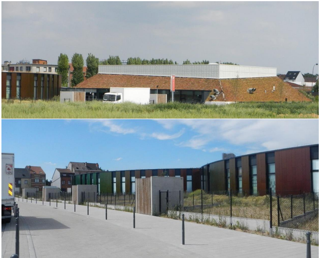
Figure 4-16 : Toiture verte sur la salle de sport de l'école et les nouveaux jardins potagers à côté de l'école (Source: visite sur le terrain juin 2017).
