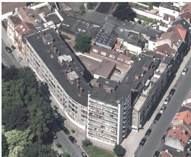
Figure 12 : Vue aérienne des bâtiments concernant le PPA (Bing Cartes, 2018)
