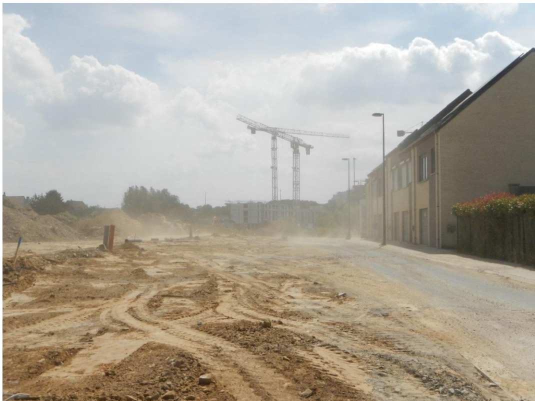
Figure 4-9 : Nuisances dues à la poussière à cause du chantier à hauteur de la rue Delwart et de la rue des Trèfles (Source: visite sur le terrain juin 2017).
