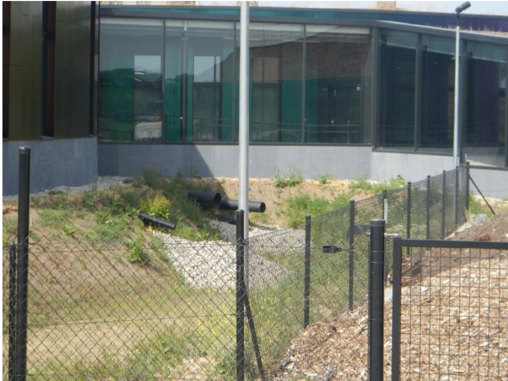
Figure 4-8 : Bassin d'orage à l'air libre à hauteur de l'école (Source: visite sur le terrain juin 2017).
