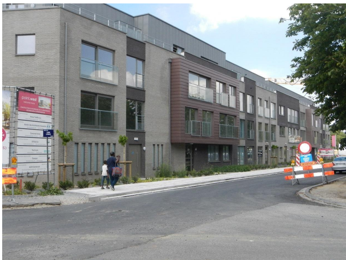
Figure 4-3 : Nouveaux appartements à hauteur de la Route de Lennik (Source : visite sur le terrain juin 2017).
