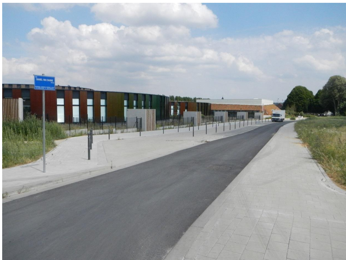
Figure 4-2 : Nouvelle école située entre la Rue Delwart, la Rue James Cook et la nouvelle Rue Daniel Van Damme (Source : visite sur le terrain juin 2017).
