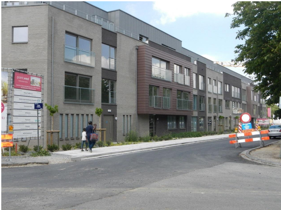
Figuur 4-6 : Nieuwe appartementen ter hoogte van de Lenniksebaan (Bron : terreinbezoek juni 2017).
