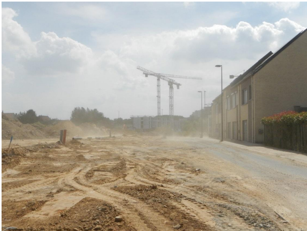
Figuur 4-9 : Stofhinder ten gevolge van de werf ter hoogte van de Delwartstraat en Klaverstraat (Bron : terreinbezoek juni 2017).
