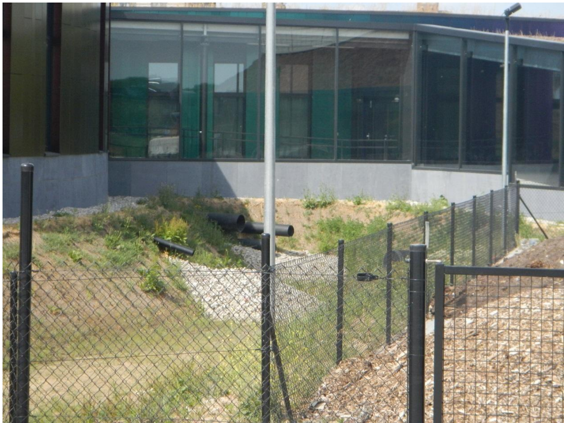
Figuur 4-8 : Open stormbekken aan de school (Bron: terreinbezoek 2017).
