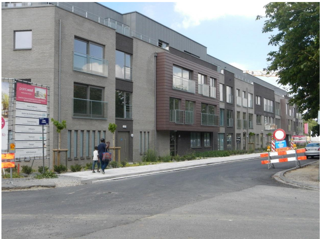
Figuur 4-3 : Nieuwe appartementen ter hoogte van de Lenniksebaan.
