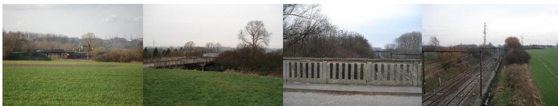
Afbeelding 6 – Bestaande situatie – aangezichten 2009-2011
