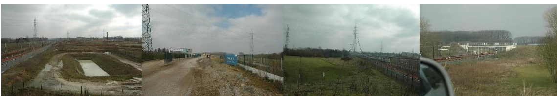
Afbeelding 7 – Bestaande situatie – aangezichten 2011-2016
