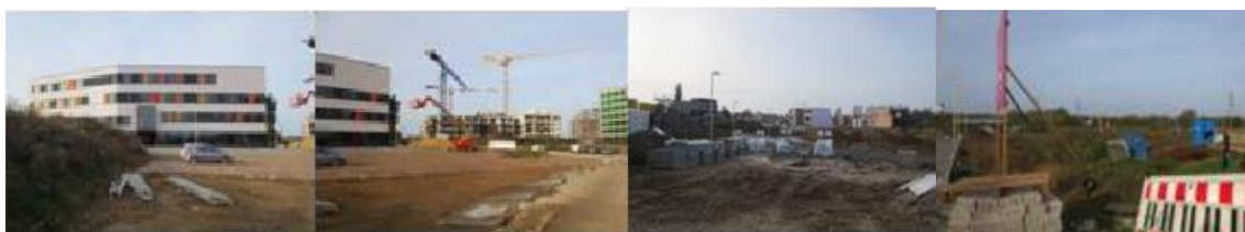
Afbeelding 2 Aanzichten van de site – residentiële bebouwing in aanbouw, bron: Skope 2017
