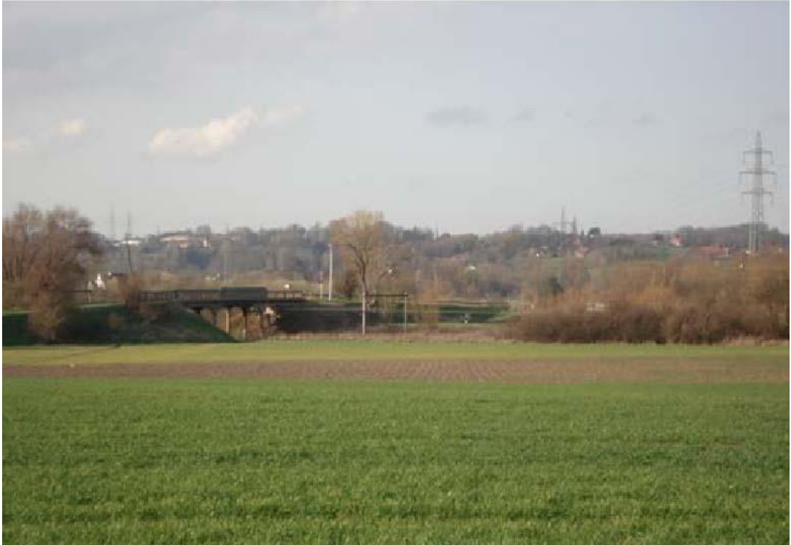
De brug in de Ketelstraat
