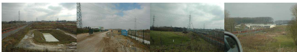
Situation existante - vues 2011-2016
