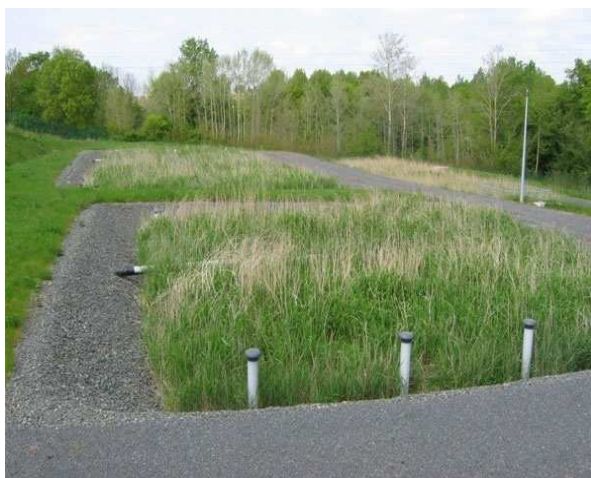
Système d'épuration par marais filtrants artificiels
