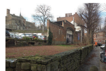
Friche face à la Collégiale à valoriser. Mur à reconstruire.
