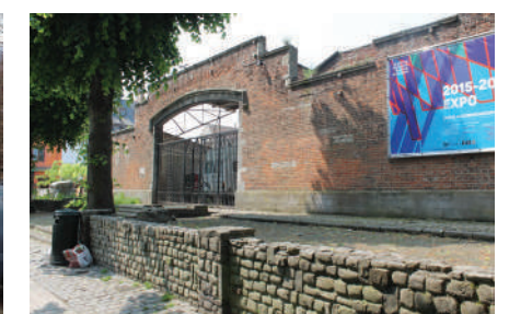
Mur à rénover.
