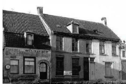
Angle de la rue Porselein et de la place de la Vaillance avant démolition : aspect villageois du centre dû aux gabarits et à l'uniformité architecturale.
