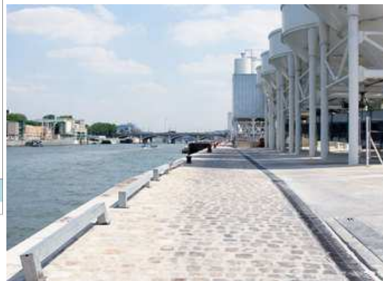
Aanleg van de havenkaaien Victor en d'Issy-les-Moulineaux en aanleg van de havenkaai Tolbiac in Parijs (13ème)
