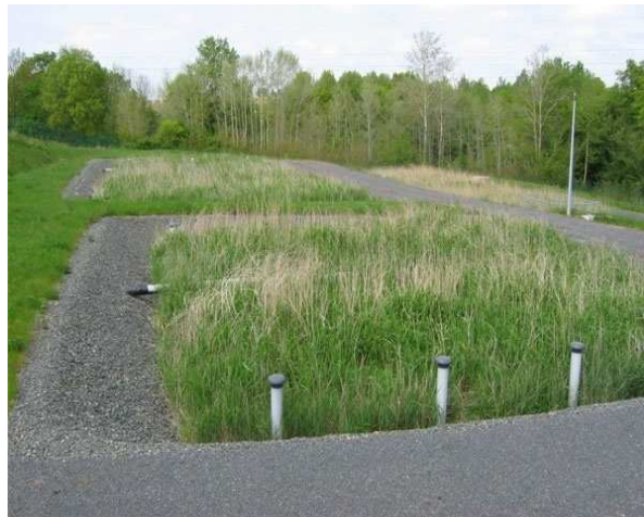
Waterzuiveringsstelsel via filterende kunstmoerassen
