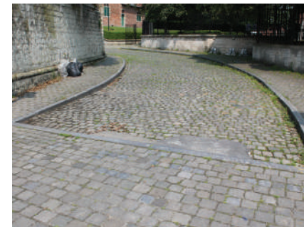
Voorplein en Kapelaanstraat: de bestrating is erg beschadigd en de vorm van de weg loopt niet meer vloeiend rond de kerk
