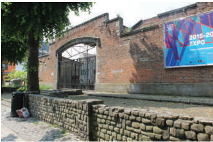
Te renoveren muur.
