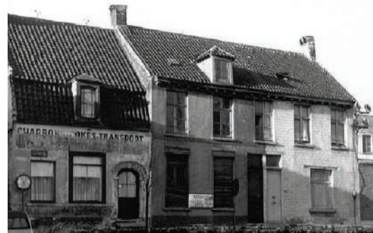
Hoek van de Porseleinstraat en het Dapperheidsplein voor afbraak: dorpsuitzicht van het centrum door de bouwprofielen en de architecturale eenvormigheid.
