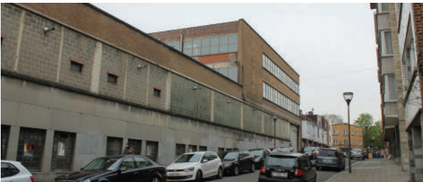
De vensters zijn dichtgemaakt bij de laatste renovatiewerken.
