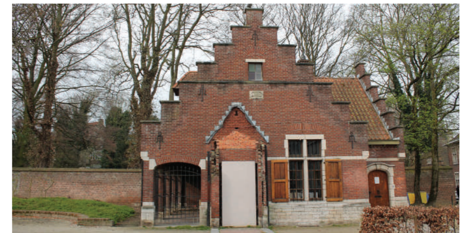
Het gemeentelijk gebouw voor herbestemming. De gevel wordt gemarkeerd door de verdwijning van een niet gereconstrueerde boog.
