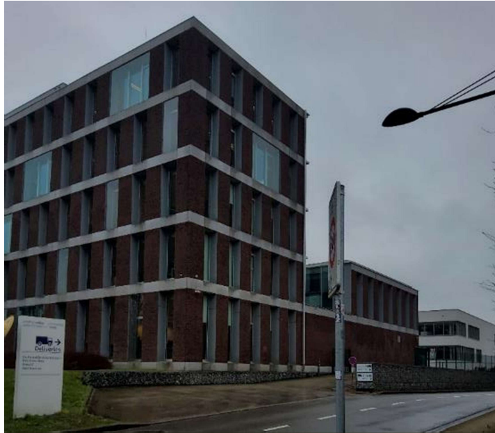
Lenniksebaan nr. 788a, het gebouw van de ziekenhuiszone dat het dichtst bij de perimeter van het BBP is gelegen (Brat 2024)
