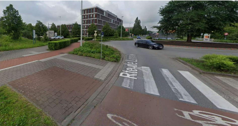
Gescheiden tweerichtingsfietspad, Lenniksebaan (Google Street View, 2024)
