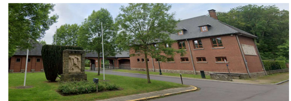
Monument en ingangsbouw van de begraafplaats, opgenomen in de wettelijke inventaris (GoogleMaps 2024)
