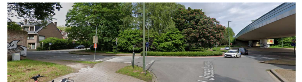
Kruising tussen een oprit van de Ring, de Josse Leemanslaan en de Vogelenzangstraat (GoogleMaps 2024)
