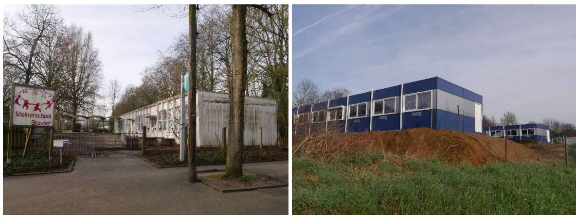
Een van de oude gebouwen van de Steinerschool (links) en tijdelijke constructies van de school (rechts)
