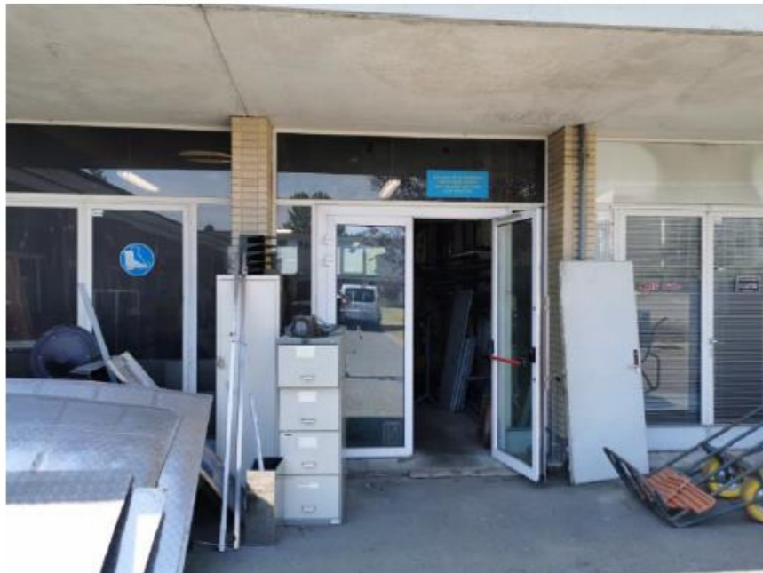
Porte entrée B9-Local soudure
