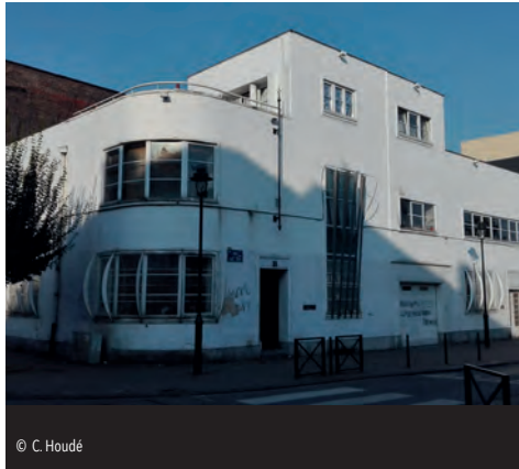
Jorezstraat (hoek met de Kliniekstraat), 21-23 – Architect Charles Gryson, 1935
